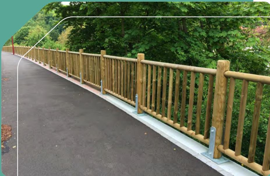
Exemple d'ancrage galvanisé à chaud
