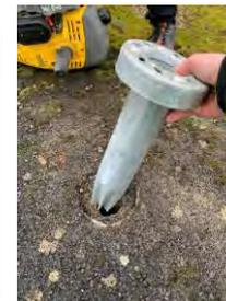
**Etape 4 :** insertion du pieux d'ancrage dans le sol
